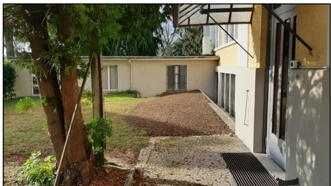
Remise en état
