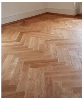
Remise en état
